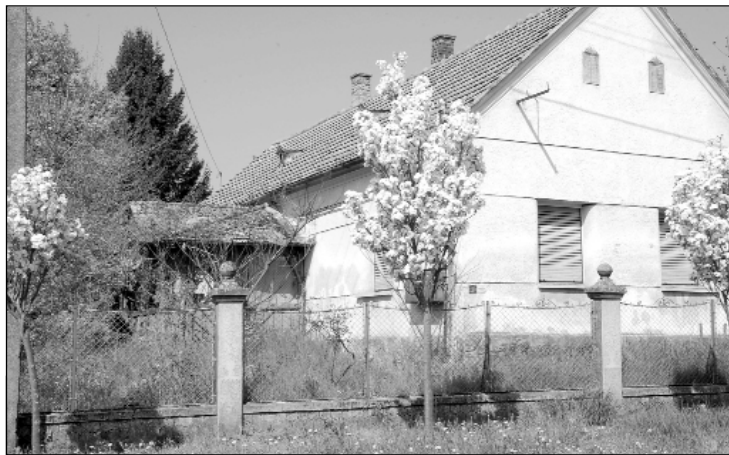
Az épület a helyreállítást követően tájházként funkcionálhatna.
