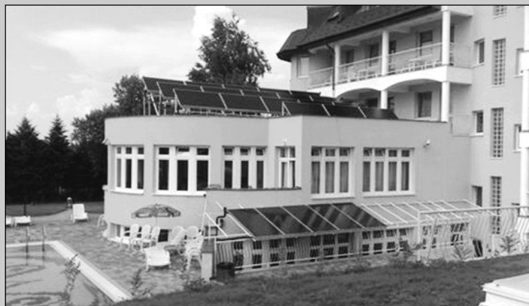
Napkollektorok és hőszivattyúk hűtik-fűtik a szállodát.
