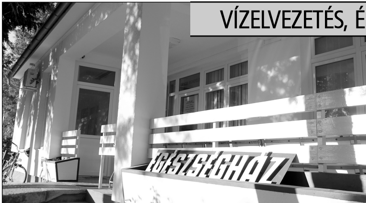
Felújították az egészségház épületét is.
