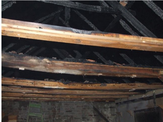
Leégett földém és tetőszerkezet
