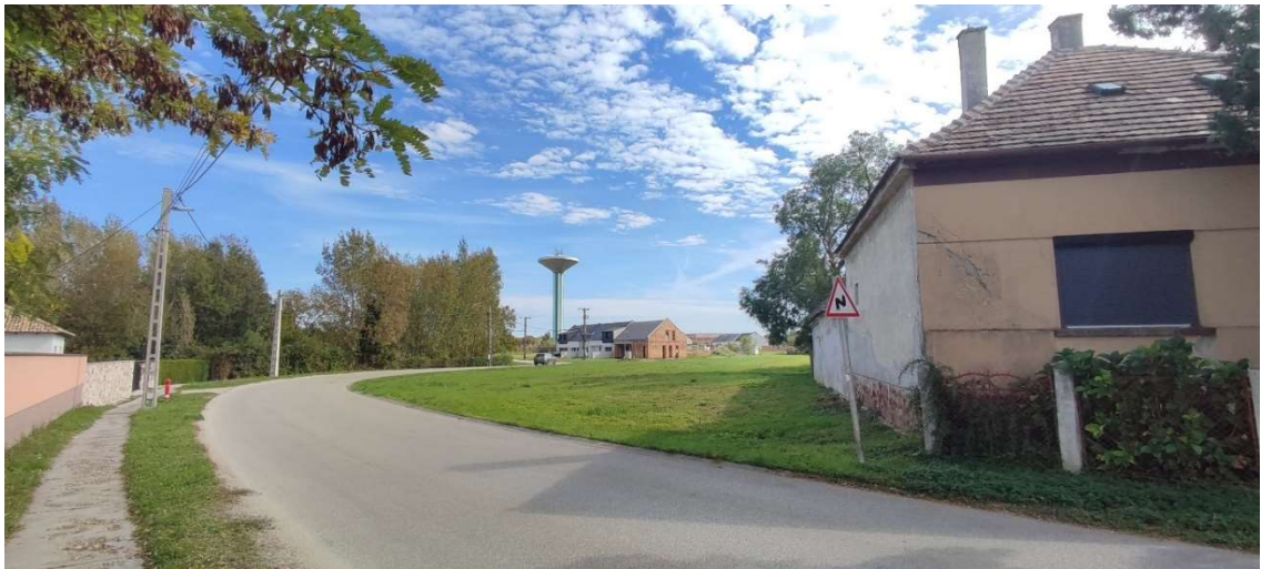
A Margit-híd utcán továbbhaladva láthatóvá válik a víztorony és a Víztorony utcai új beépítés
