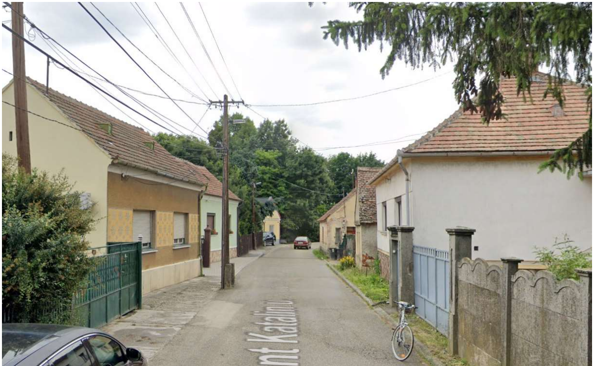
Szent Katalin utca; kialakultan szűk keresztmetszetű utca az előkert nélküli, földszintes, családi ház beépítéssel
