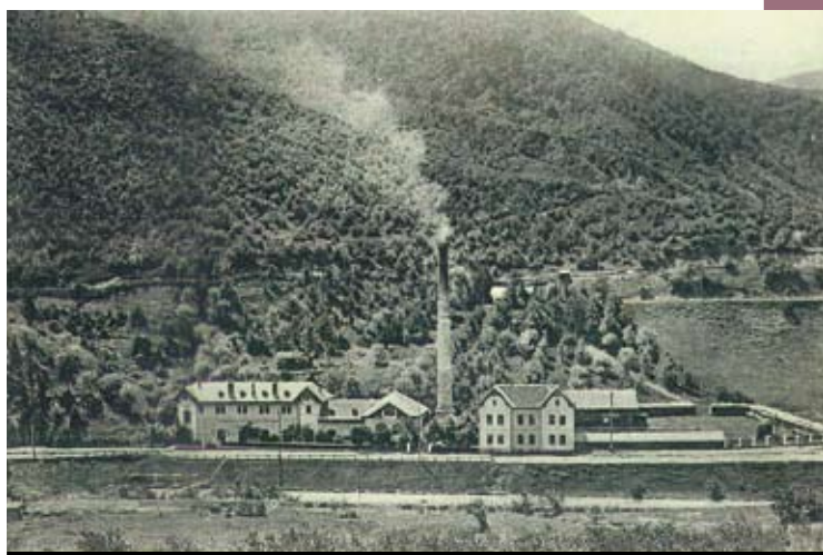
5. ábra Az 1896-ban üzembe helyezett erőmű festői környezetben épült
