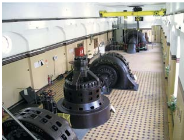
13. ábra A gépcsarnok mai képe, elől a két régi Ganz gép, közöttük az ASEA generátor, háttérben az újkori gépcsoport
