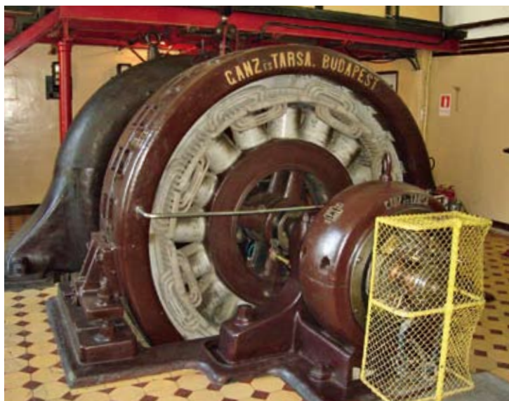
8. ábra Az 1902-ben gyártott generátor még ma is működik.
