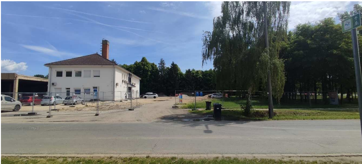
Épülő, Fürdő utcából kiágazó szervízút
