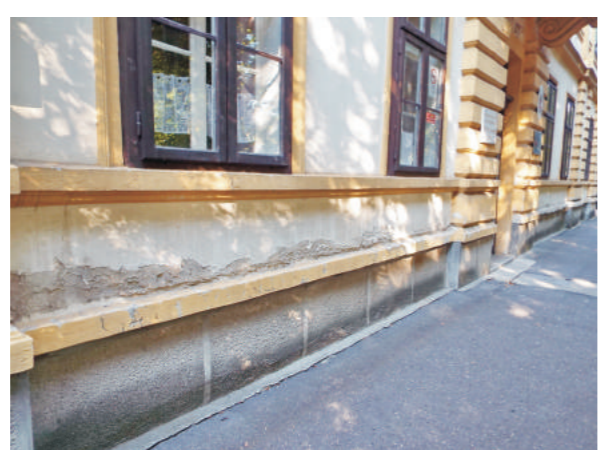
Reversion hálószonda a műkö lábazat felett a vakolati rétegek alatt elhelyezve → R-1
