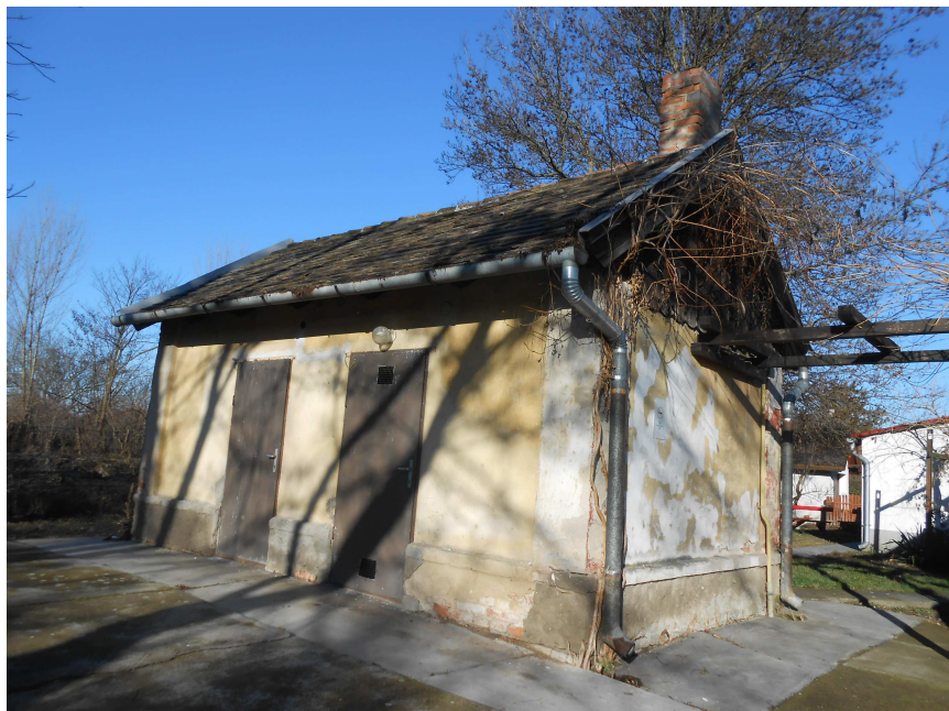
A melléképület udvar felőli nézete
