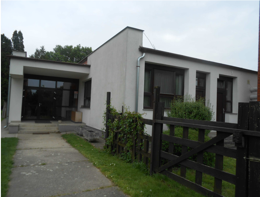
Az épületrész udvari, nyugat felőli nézete
