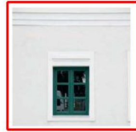
Fehér vakolat és annak árnyékrajzolatai
